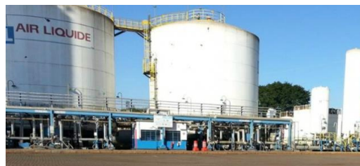
Vista Geral da Tancagem
