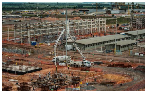
Vista geral da Obra
