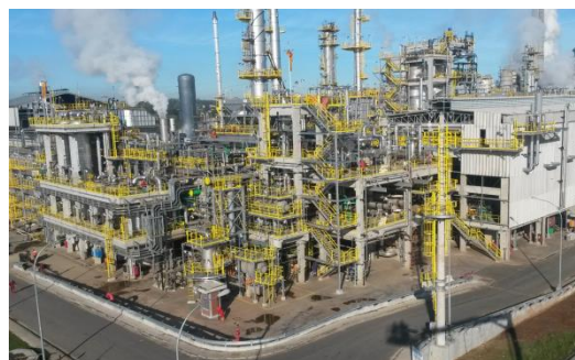
Vista geral da Obra
