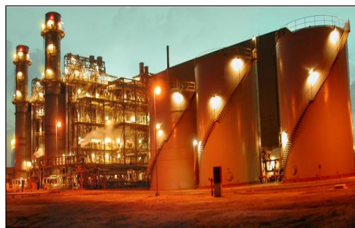
Vista geral da Usina
