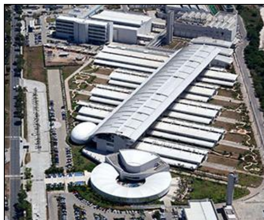
Figura 1 - Vista aérea do CENPES-II Fonte: http://www.petrobras.com.br/
