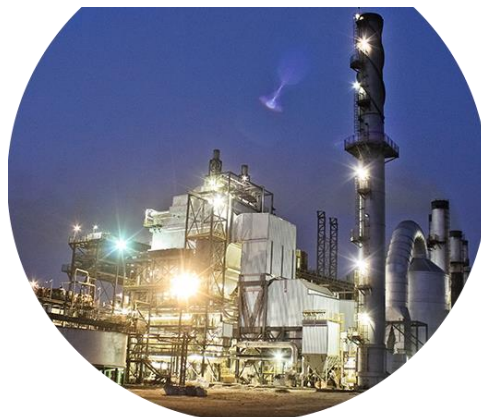
Figura 1 - Vista de uma Usina da Guarani Fonte: www.aguarani.com.br
